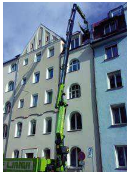
Der 28 Meter hohe Kran im Einsatz
